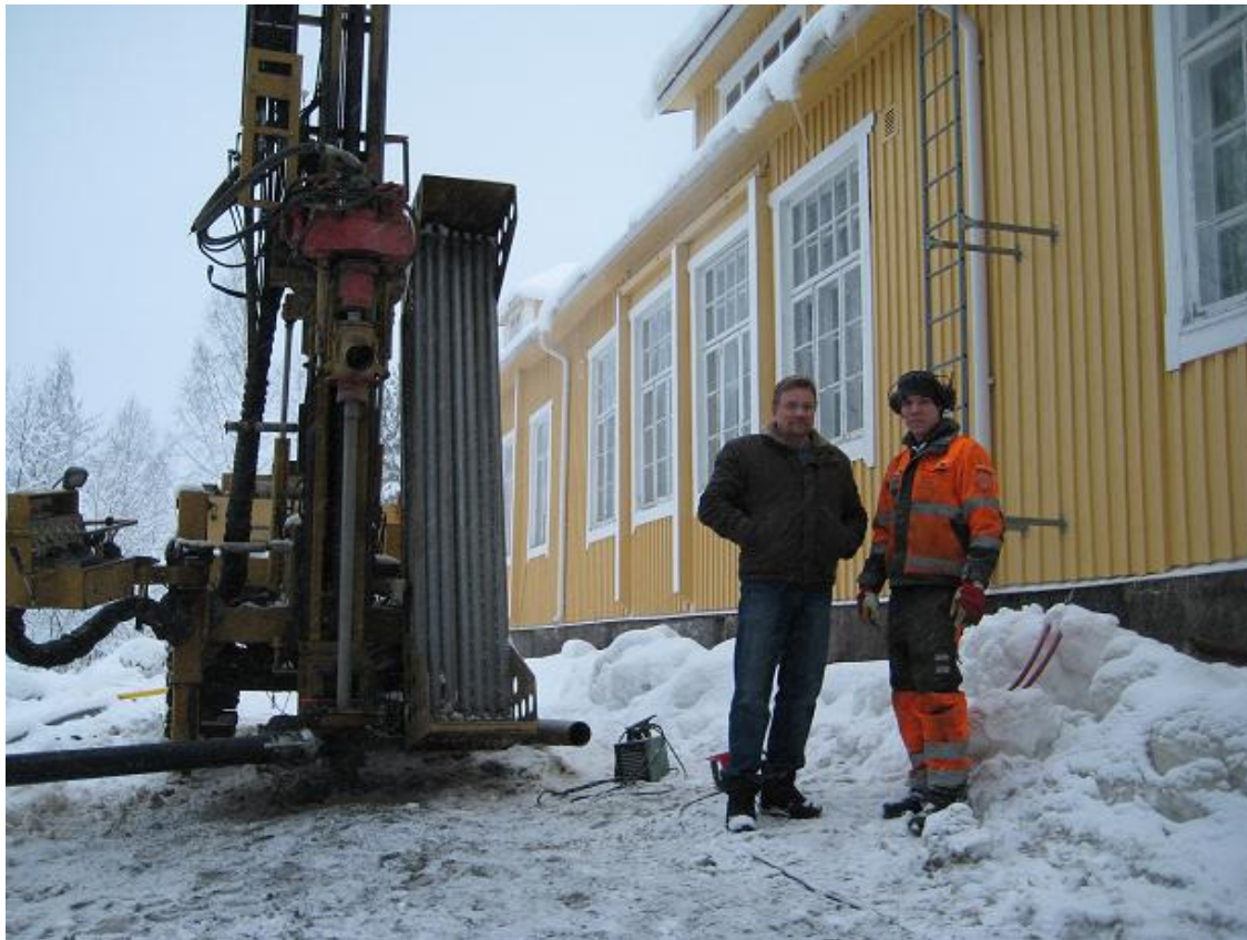
Monitoimitalon maalämmön lämpökaivojen poraus alkoi viime viikon perjantaina. Mika Raappana kyseli työstä Suomen Porauspalvelu Mika Grankullalta
